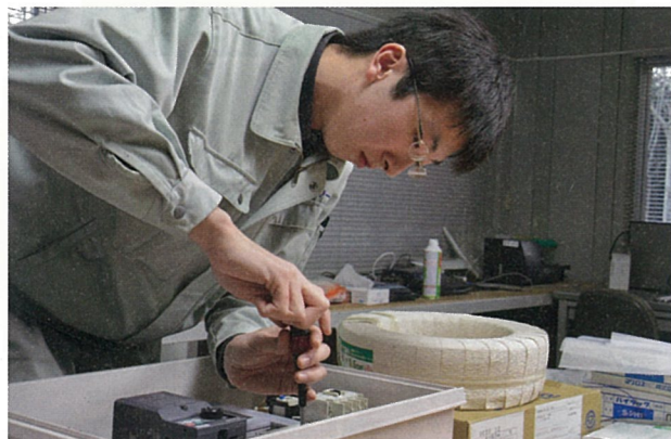
野菜洗浄機の制御盤を製作中
